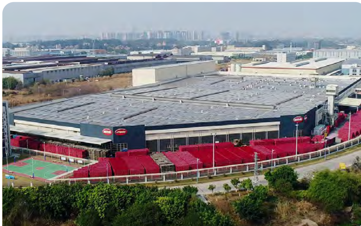
于佛山厂天台的太阳能光伏板
